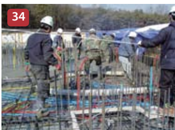
Instalación cabillas y malla en la losa
