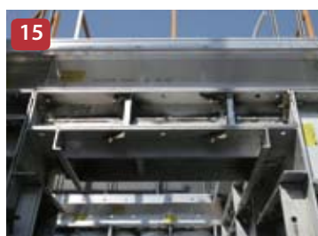
15 Instalación paneles viga
