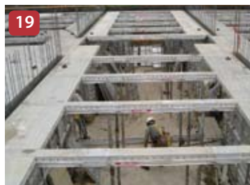
19 Instalación de vigas de losa
