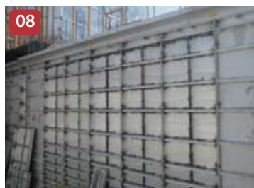
08 Configuración de paneles de pared
