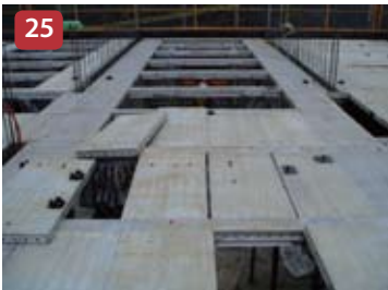
Instalación paneles de losa
