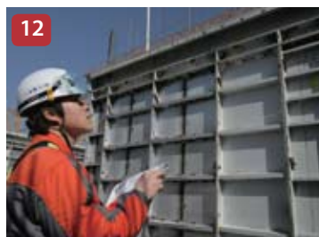
12 Inspección primaria por supervisor técnico
