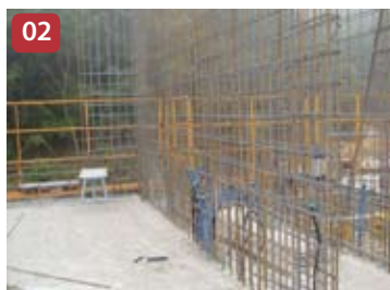
02 Ajuste de barras de pared
