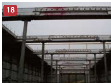
18 Instalación de vigas de losa
