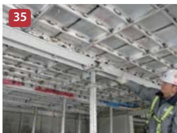
Desmontaje del encofrado
