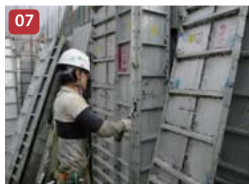
07 Configuración de paneles de pared
