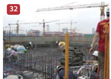
Ajuste del panel de losa
