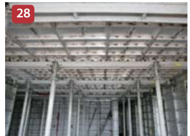
Ajuste del panel de losa
