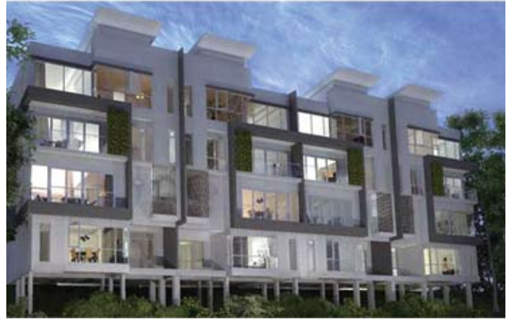
02 Proyecto : Sunway Montana Pais : Malaysia Tipo de Construcción : Encofrado de Aluminio
