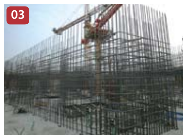
03 Configuración de paneles de pared
