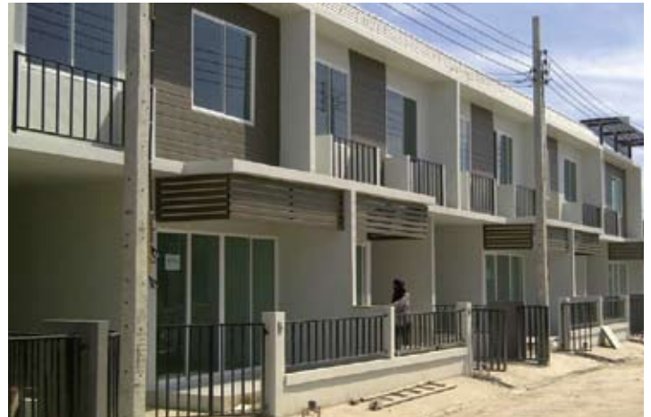
06 Proyecto : The Colors Townhouses Pais : Thailand Tipo de Construcción : Encofrado de Aluminio
