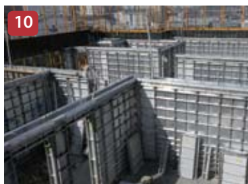
10 Instalación de paneles de muro (pared)
