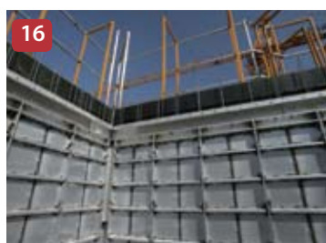
16 Instal. paneles internos de losa
