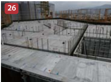
Instalación paneles de losa
