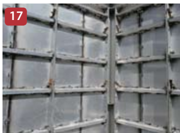
17 Instalación de Esquinas
