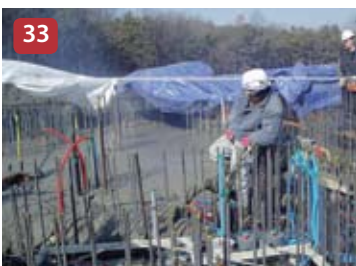
Vaciado de hormigón
