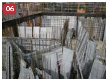
06 Configuración de paneles de pared
