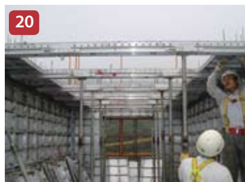
20 Instalación de vigas de losa
