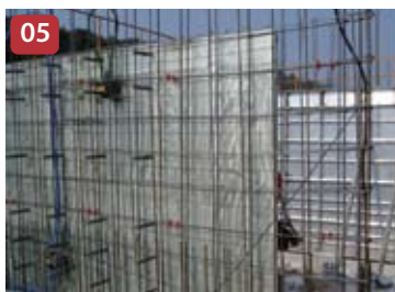
05 Configuración de paneles de pared
