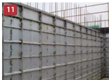
11 Instalación de paneles de muro (pared)
