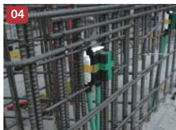
04 Inspección primaria por supervisor técnico
