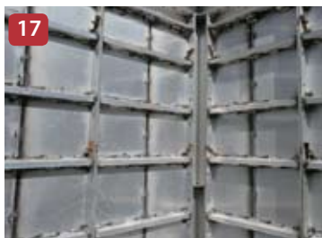
17 Inst. da Ancoragem da Laje
