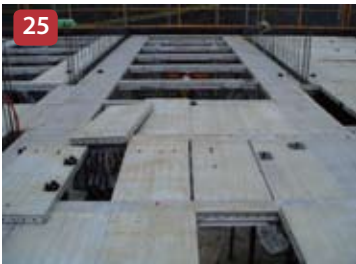
Instalação dos Painéis da Laje
