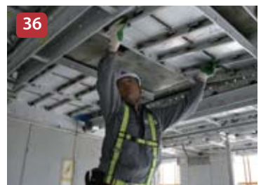
Desforma dos painéis de laje para as paredes em sequência
