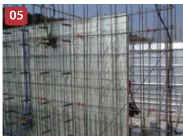
05 Instalação dos Painéis de Parede
