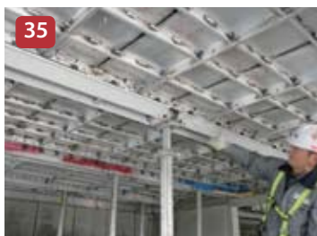
Desforma dos painéis de laje para as paredes em sequência
