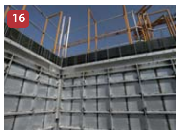
16 Instalação dos Cantos da Laje
