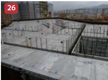
Instalação dos Painéis da Laje
