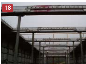
18 Instalação das Viga de Laje
