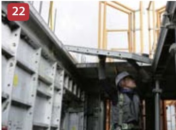
Instalação dos Painéis da Laje
