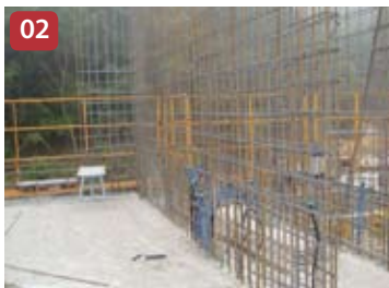
02 Instalação da Armação
