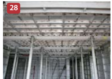
Ajuste de nivelamento da Laje
