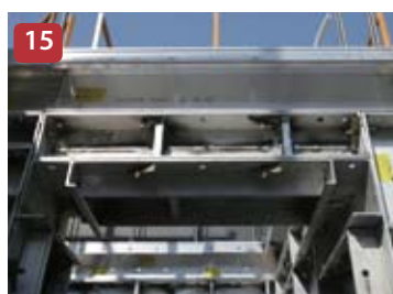
15 Instalação das Vigas
